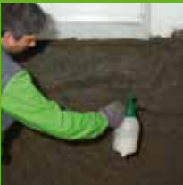
напыление грунтовки KÖSTER Polysil TG 500
