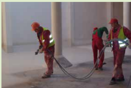
Резервуар для питьевой воды, Тамов, Польша
