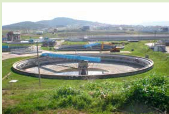
Очистное сооружение, Стамбул, Турция
