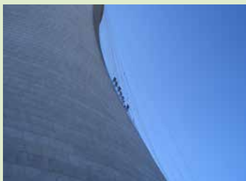
Градирни электростанции, Китай
