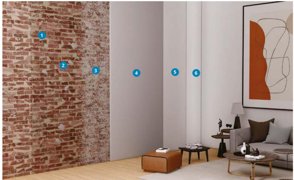
Bei schwach feuchtem Mauerwerk reicht oft eine Instandsetzung mit KÖSTER Sanierputz. Dazu wird der alte Putz vollständig entfernt, Fugen werden ausgekratzt und von losen Bestandteilen befreit, sodass eine tragfähige offenporige Oberfläche verbleibt. Schimmelbelastete Flächen sind fachmännisch zu bearbeiten.
