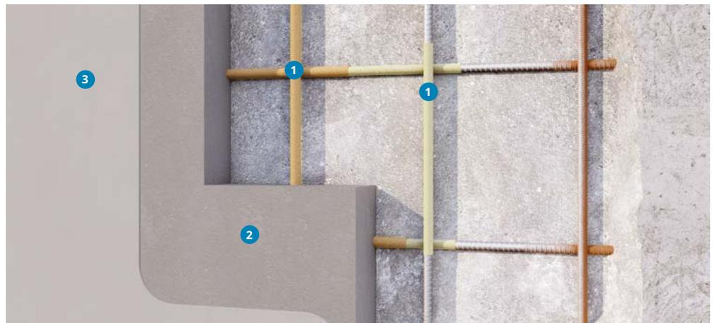
Die großflächige Reprofilierung und Ausbesserung von Beton stellt Anforderungen an die Verarbeitung, den Korrosionsschutz der Bewehrung und das Ersetzen der Betonüberdeckung durch wasser- und chemikalienbeständige Spezialmörtel. Die Zertifizierung zur
