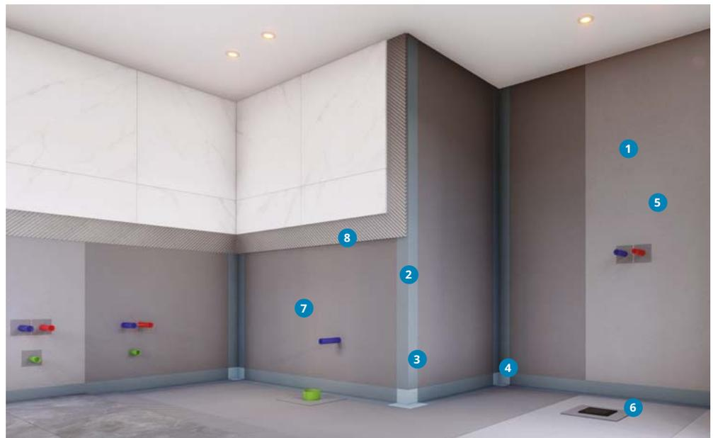
Nur wenige Bauteile sind so regelmäßig dem Wasser ausgesetzt wie Bäder, Feucht- und Nassräume. Eine professionelle rissüberbrückende Abdichtung ist hier in jedem Fall erforderlich. Die Abdichtung soll zudem tragfähig genug sein, damit Fliesen auf die Abdichtung aufgebracht werden können.
