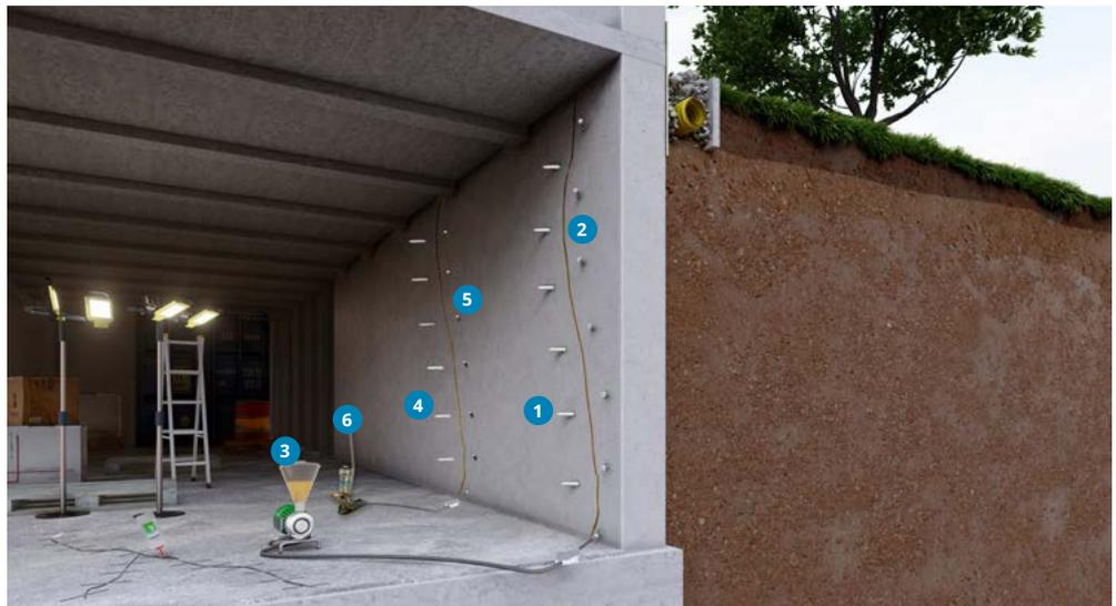
Trockene und feuchte Risse werden mit den Injektionsmaterialien von KÖSTER dauerhaft verschlossen. KÖSTER 2 IN 1 wird standardmäßig verwendet, um Risse gegen Wasser abzudichten. Das PU-Material bildet bei Wasserkontakt einen hoch elastischen Schaum, der das Wasser stoppt und aus dem Riss verdrängt. Ist im Riss aber kein Wasser vorhanden, bildet sich ein elastisches Massivharz für den dauerhaften Rissverschluss.
