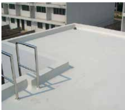
Готовая гидроизоляция кровли
