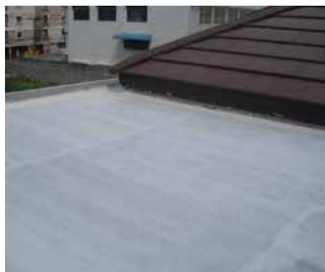
Нанесение первого слоя
