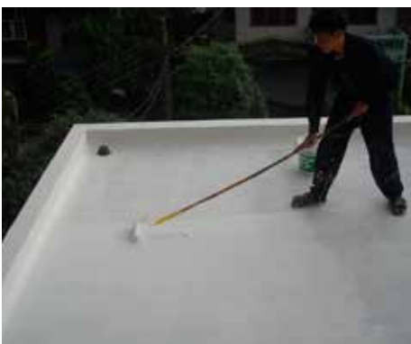
Нанесение второго слоя. Перед этим укладывается армирующая стеклоткань.
