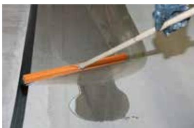
**7. В качестве грунтовки наносится KÖSTER LF-BM. При ожидаемом капиллярном подсосе или высокой щелочности используется KÖSTER VAP 2000 в качестве грунтовки.**
