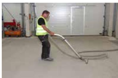
**5. Для создания идеальной адгезии между основанием и полимерным покрытием удаляется пыль и мусор.**
