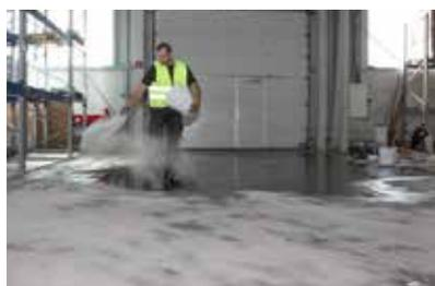
**8. Свежая грунтовка посыпается прокаленным кварцевым песком, для улучшения сцепления с последующим слоем.**
