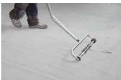
**4. После подготовки дробеструйным методом поверхность очищается с помощью специального магнитного валика. Дробь может использоваться повторно.**
